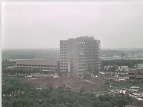
建設中の筑波大学附属病院
