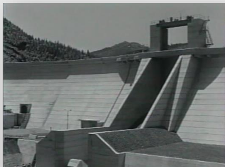
水沼ダム(北茨城市)
