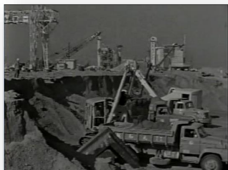
鹿島港建設工事
