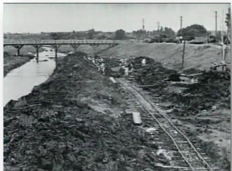
河川改修工事
