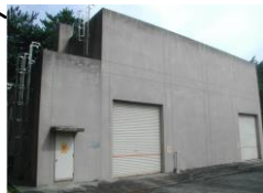
固体廃棄物一時保管棟
