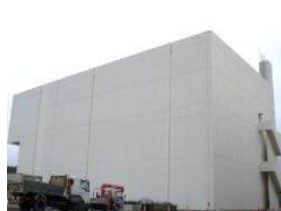
解体分別保管棟
