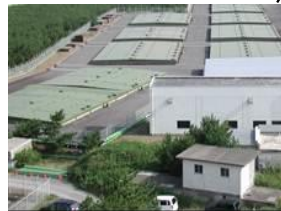
保管廃棄施設・L
