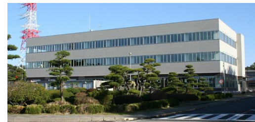
緊急時対策所
