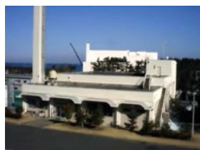
第1廃棄物処理棟
