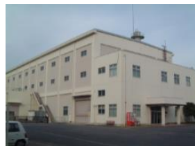
第2廃棄物処理棟
