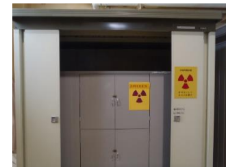
発生廃棄物保管場所 (例)第3廃棄物処理棟 保管庫
