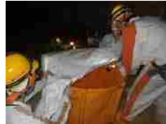
⑦給水作業
