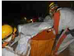
⑦給水作業
