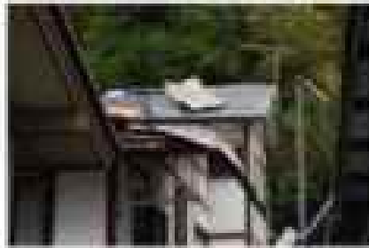
飛来物（鋼板製屋根材）の衝突
