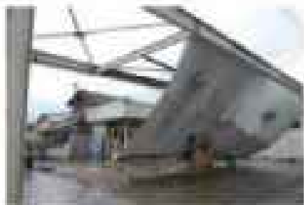
ガソリンスタンドの折伏屋根の脱落
