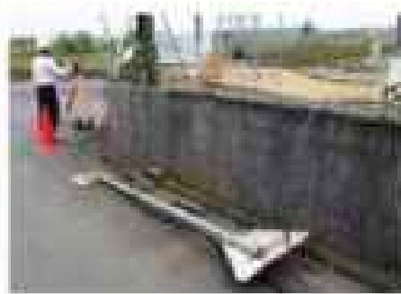
道路標識の倒壊
